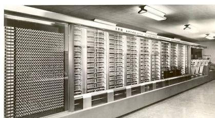
Ce calculateur également programmable à base de rubans perforés, développé en parallèle du précédent, utilisait encore le système décimal.
